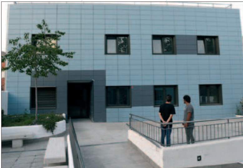
El nou edifici ja té les obres acabades i la FVO treballa en el seu equipament
